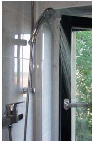
■ **Welche Bedingungen begünstigen ein vermehrtes Auftreten von Legionellen?** Ideale Bedingungen bestehen bei Temperaturen zwischen 25 und 55 Grad und einem geringen Austausch des Leitungswassers. Die geringe Abnahme bzw. der geringe Austausch können durch Leerstand oder durch längere Abwesenheit entstehen.
