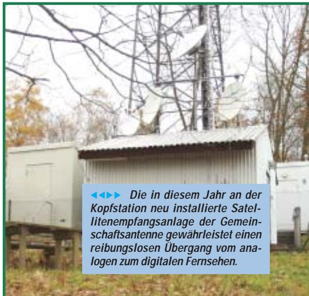
◀▶▶ Die in diesem Jahr an der Kopfstation neu installierte Satellitenempfangsanlage der Gemeinschaftsantenne gewährleistet einen reibungslosen Übergang vom analogen zum digitalen Fernsehen.
