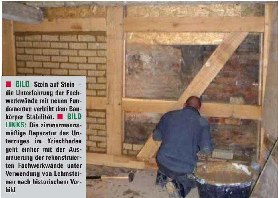
■ **BILD:** Stein auf Stein – die Unterfahrung der Fachwerkwände mit neuen Fundamenten verleiht dem Baukörper Stabilität. ■ **BILD LINKS:** Die zimmermannsmäßige Reparatur des Unterzuges im Kriechboden geht einher mit der Ausmauerung der rekonstruierten Fachwerkwände unter Verwendung von Lehmsteinen nach historischem Vorbild
